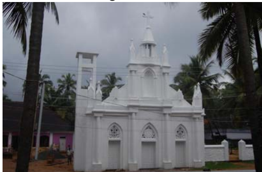
Foto 1: het reeds gerenoveerde exterieur
